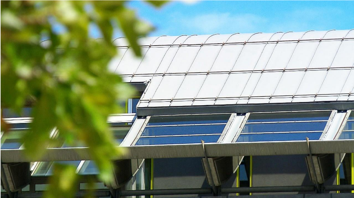
Dachgeschoßwohnungen müssen oft stark gekühlt werden
